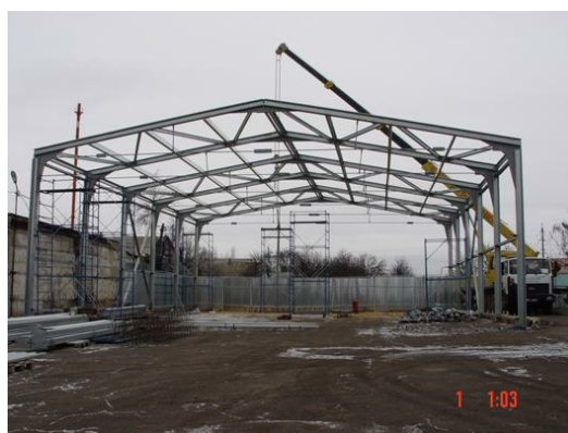
Рисунок 4 - Ферменные конструкции ангаров [1]
