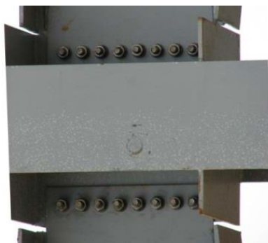
Рисунок 11- Болтовое соединение в конструкции ангара [5]
