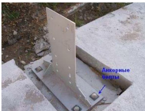
Рисунок 12 - Анкерное крепление [6]
