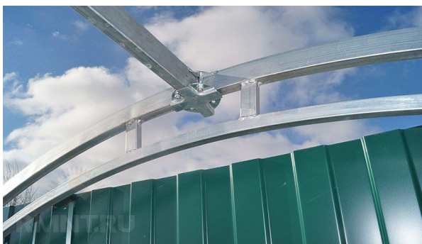
Рисунок 10 – Крепление верхнего пояса ангара к аркам [3]
